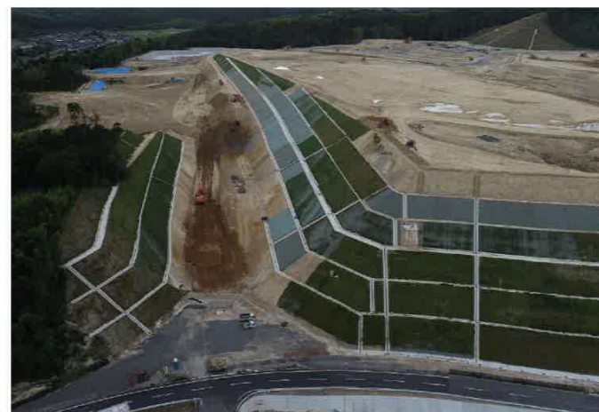
消防署北交差点（新設）から西方向を望む
