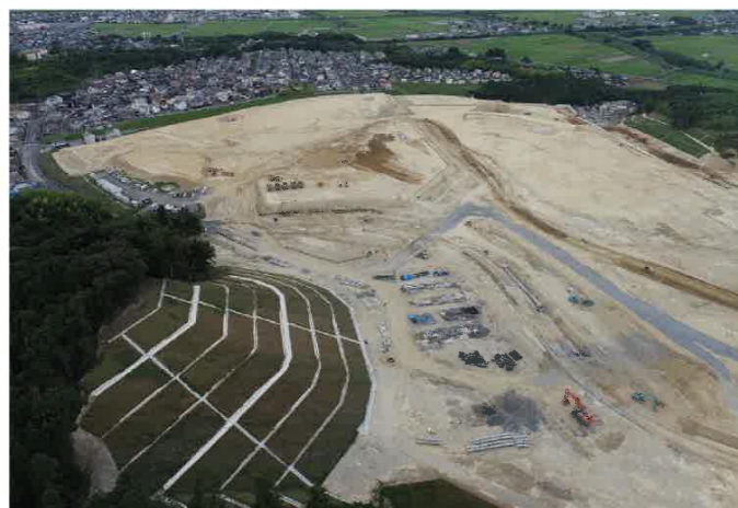
地区北西方向から南東方向を望む
